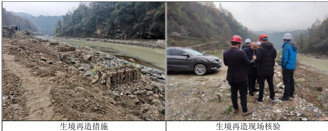
图 5.2-5 生境再造设施现场
