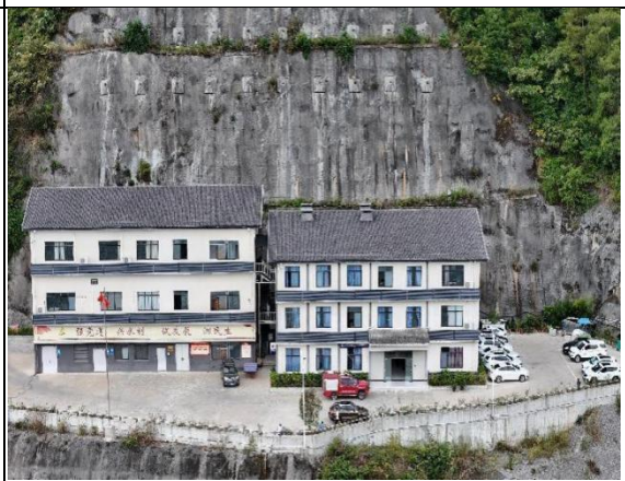
管理站、警务室
