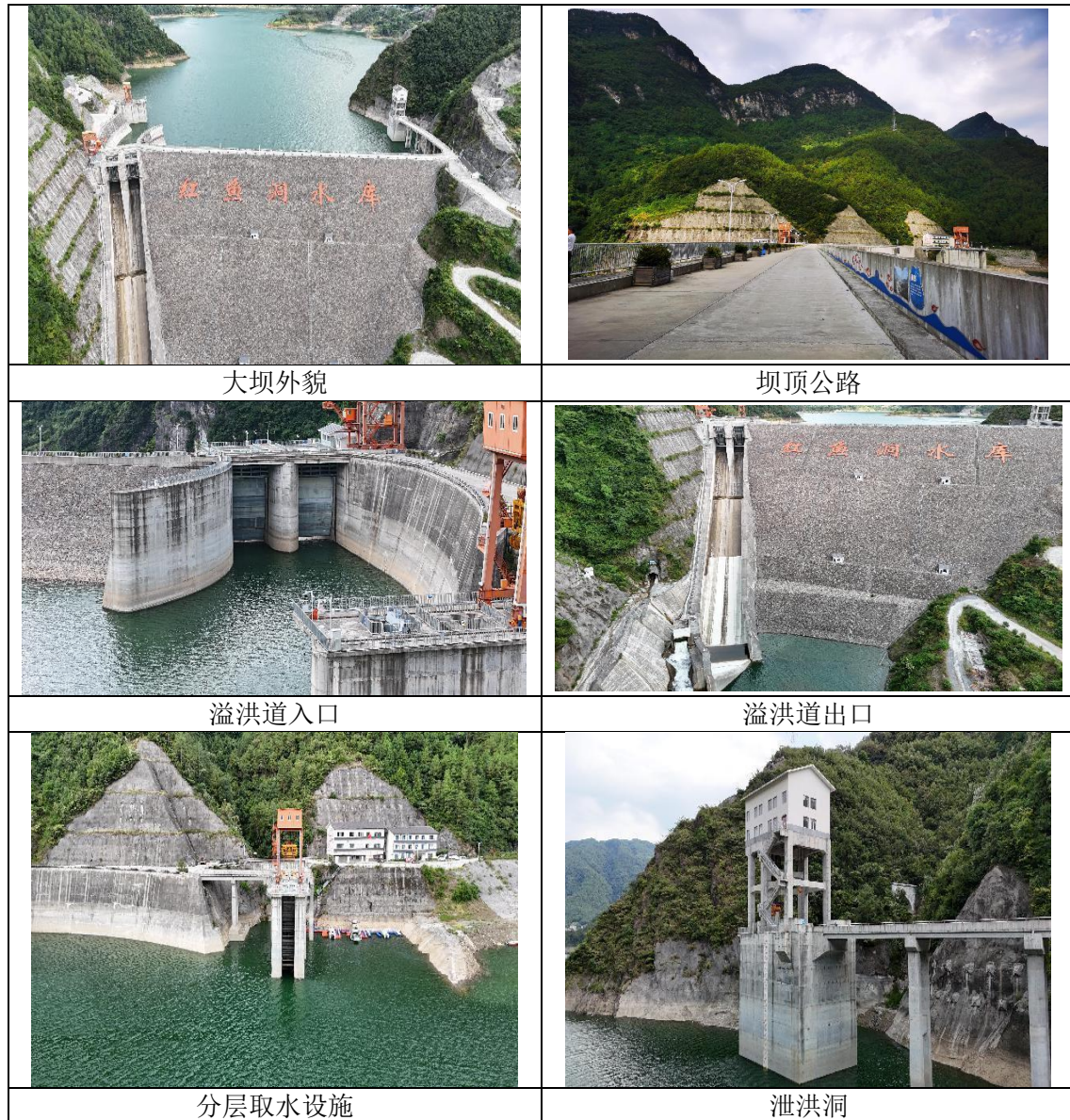
图 3.5-1 红鱼洞水库库区工程建设面貌
