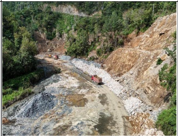
沙子岭尾矿库（闭库施工）
