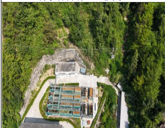
桥亭集镇安置点污水处理厂
