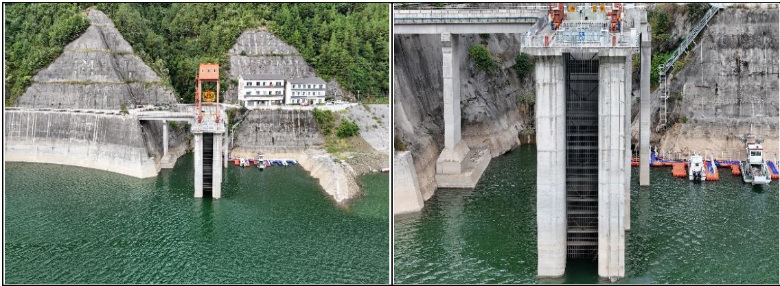
图 5.2-1 分层取水设施现场照片
